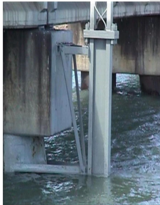
Stal strukturalna w strefie rozbryzgowej
